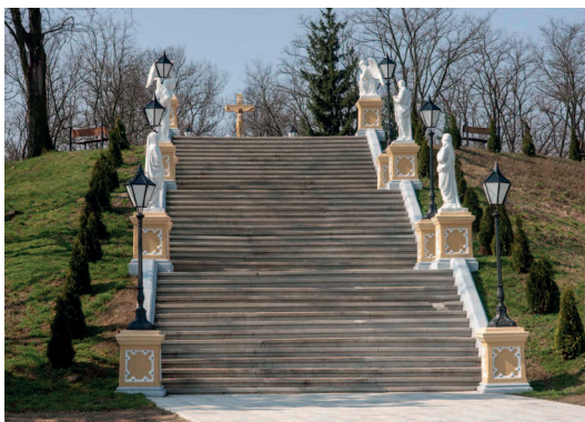
Vstup na vyvýšeninu vedie po barokovom schodisku širokom 5,7 m s plastikami anjelov (foto: J. Lacika)
