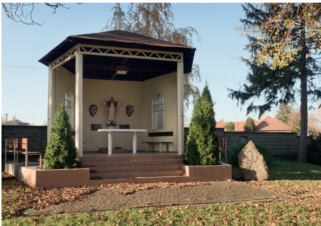
Kaplnka Božského Srdca Ježišovho (foto: P. Vince)
